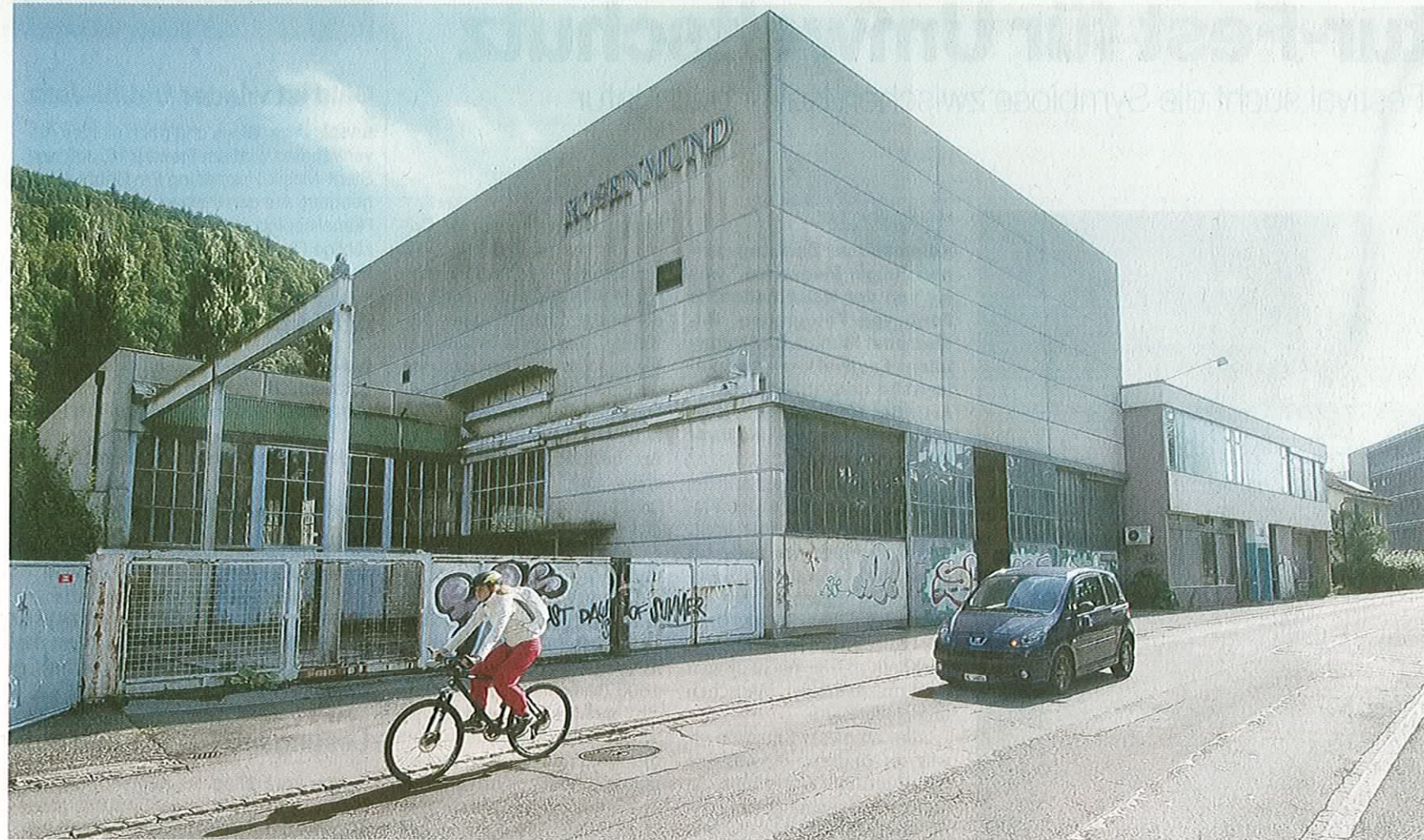
Umnutzung geplant. In der heutigen Industriehalle an der Rosenstrasse sollen künftig kleine Kunstturner und Trampolinspringer trainieren. Foto Hannes-Dirk Flury
